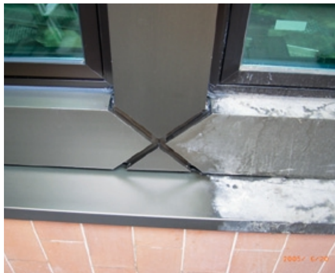
Maßarbeit vom Spezialisten: Beispiel für eine erfolgreiche Grundreinigung an einer lange Zeit vernachlässigten Alu-Fassade.
